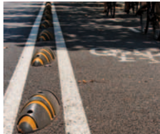
Afscheidingen voor fietspaden, gemaakt uit gerecycleerd afval.
