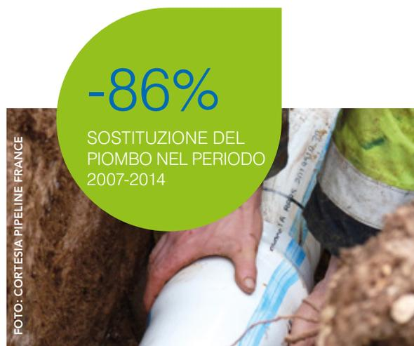
Il PVC è ampiamente utilizzato per le tubazioni di scarico dato il suo basso costo, la resistenza chimica e facilità di giunzione
