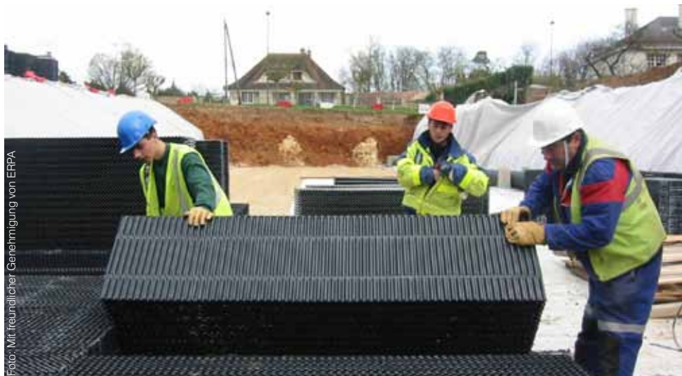
Ultraleichte wasserführende Module aus recycelten Hart-PVC-Filmen
