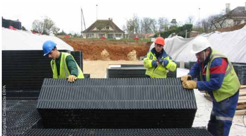
Módulos ultraligeros para llevar agua hechos de films rígidos de PVC reciclado
