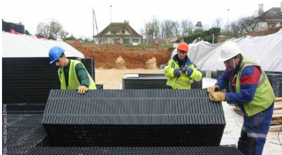
Superlichtgewicht waterdraagmodules gemaakt uit gerecycleerd hard PVC
